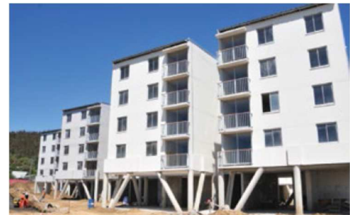
Figura 12 – Ejemplos de soluciones ingenieriles y constructivas tsunami resilientes en Dichato y Coliumo
